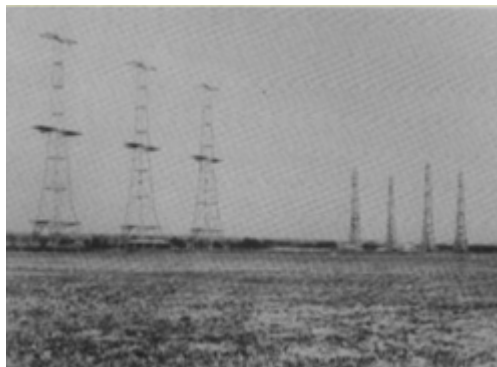
Antennes des émetteurs et des récepteurs d'un radar de la Home Chain
