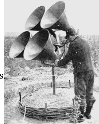
Systemes de détection acoustique du réseau d'alerte aux bombardements à Paris.
